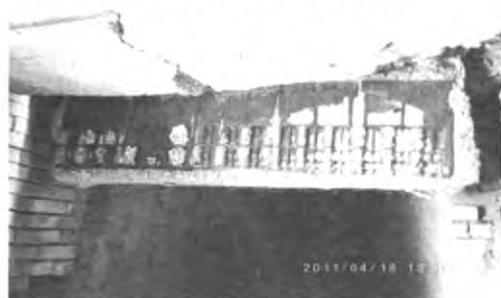
图12 改造后的三次风闸板底部
