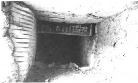
图13 三次风管内被冲刷和磨蚀的耐火材料
