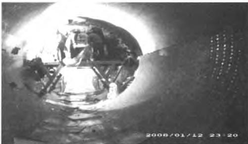
图1 窑内采用砌砖机砌砖
