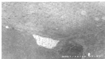
图5 浇注料脱落的窑头罩
