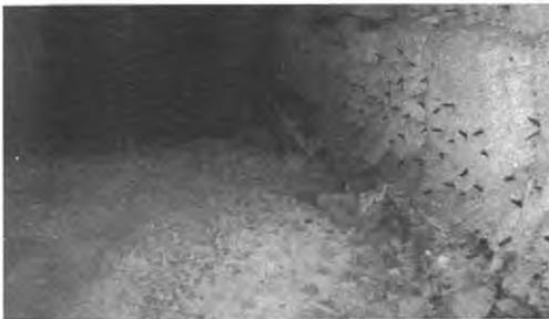
图14 篦冷机内侧墙被冲刷和磨蚀的耐火材料
